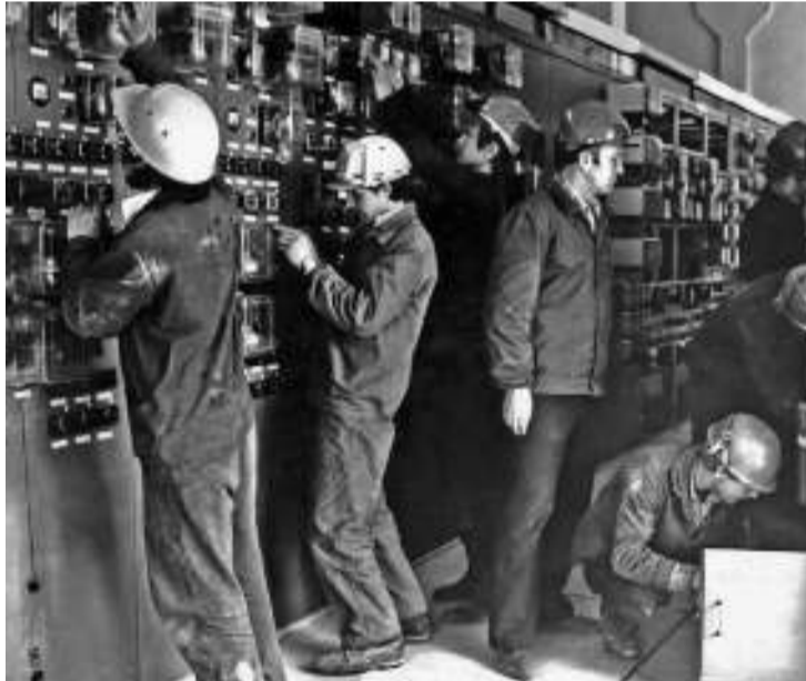
Современный оператор дистанционного пульта управления видит параметры работы оборудования на экране компьютера. А в 1977 году все приборы были аналоговыми, каждый со своей шкалой
