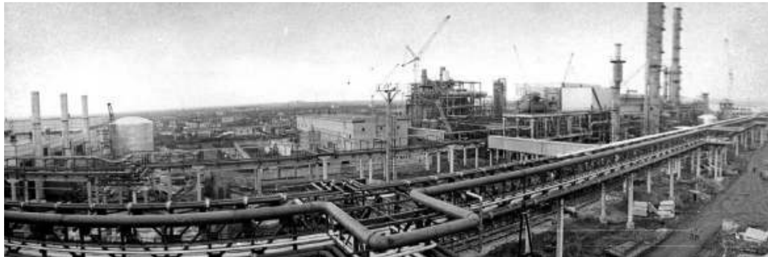
Строительство первого агрегата аммиака в приоритете.
